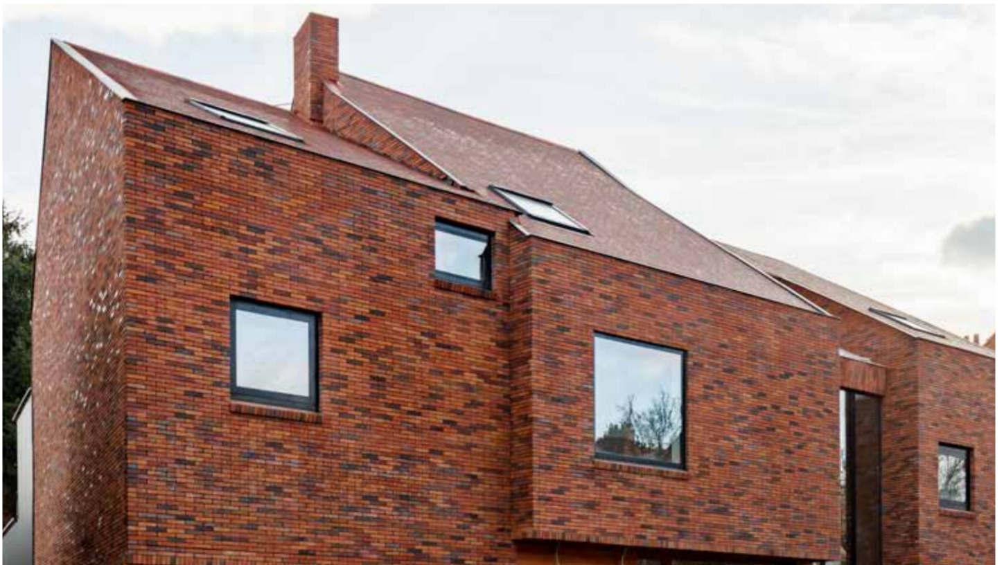
Nieuwbouwproject in opbouw Combinatie van massief metselwerk en Façabrick met steenstrippen Bouwheer: Het Elfennestje, Lichtaart Architect: blancoooARCHITECTUUR, Antwerpen Steenstrippen: mix van Terca Milosa steenstrippen: 70% Passiebloem, 20% Kogelbloem en 10% Goudsbloem
