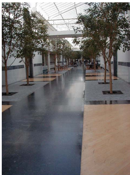
Afb. 11 Evolutie naar een lichtere kleur van het oppervlak van een vloerbetegeling van blauwe hardsteen die aanvankelijk gepolijst was, in zeer druk belopen zones.
