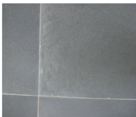
Fig. 8 Krasvorming in een keramische tegel.
