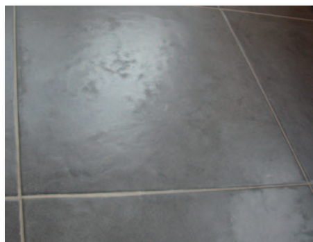
Afb. 2 Glansverlies door de slijtage van een keramische tegel.
