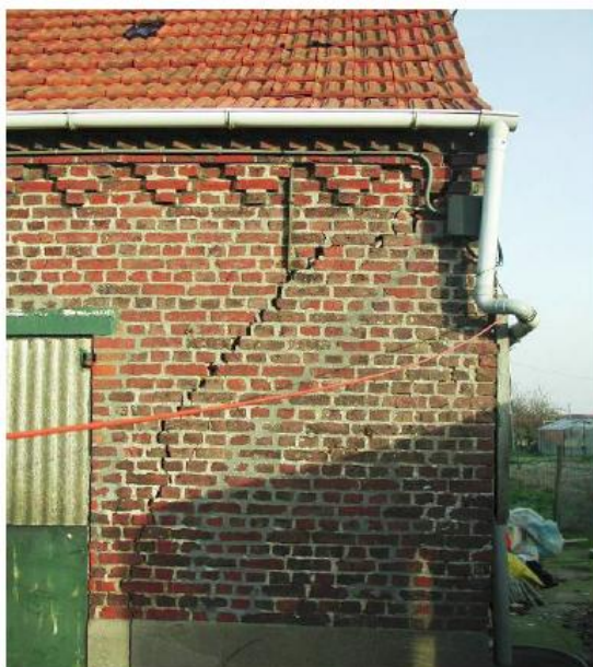
Stabiliteitsproblemen bij buitenmuren: Scheurvorming
