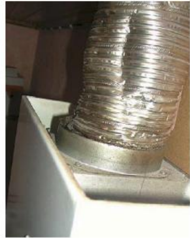
Deze verbindingen tussen aansluitkanaal, afvoerstop en/of afvoerkanaal zijn niet verdicht.
