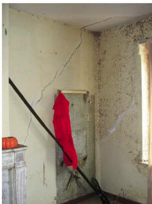
Voorbeelden van scheurvorming bij dragende binnenmuren
