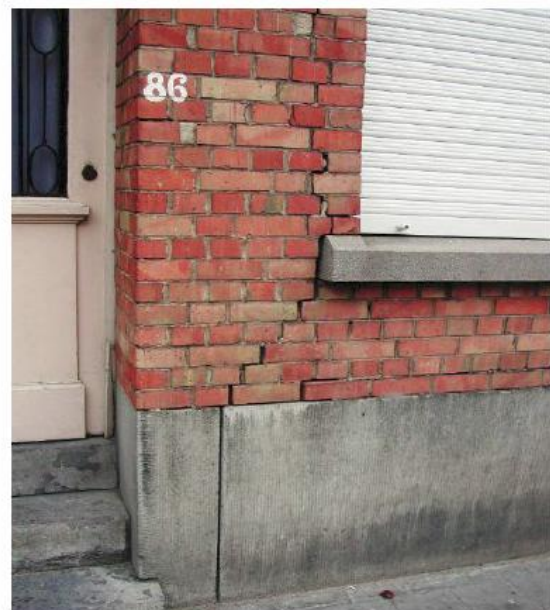
Stabiliteitsproblemen bij buitenmuren: Scheurvorming
