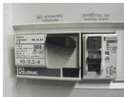
Differentieel- of verliesstroomschakelaars
