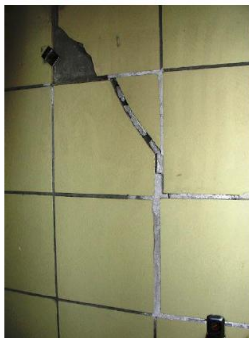
Voorbeelden van scheurvorming bij dragende binnenmuren
