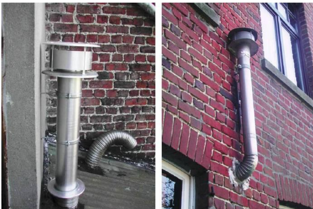
Uitmonding van afvoerkanalen met natuurlijke trek in een zone van statische overdruk (uitmondingszone, zie schema pag. 134).
