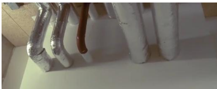
Brandwerende doorvoering
