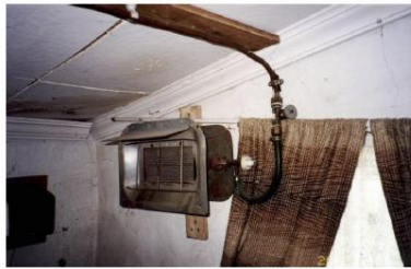
Risico's op brand / ontploffing bij gasinstallaties: links een wachtleiding die niet afgesloten is door een metalen dop; rechts een niet-reglementair toestel dat te dicht is opgesteld bij brandbare materialen, met bovendien gebruik van niet-geschikte onderdelen
