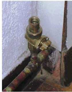
Risico's op brand / ontploffing bij gasinstallaties: links een wachtleiding die niet afgesloten is door een metalen dop; rechts een niet-reglementair toestel dat te dicht is opgesteld bij brandbare materialen, met bovendien gebruik van niet-geschikte onderdelen
