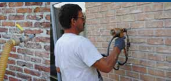
Isolatie inspuiten in de spouw.
