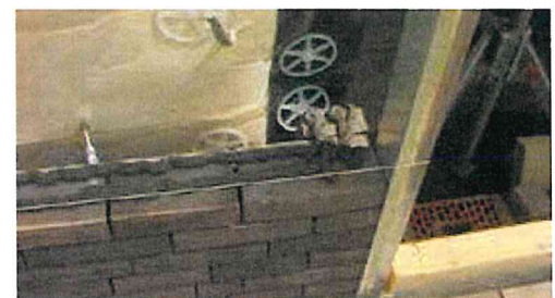
Foto 2: mechanische bevestiging van de folie
