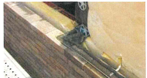
Foto 1: correcte plaatsing folie onder de dorpel
