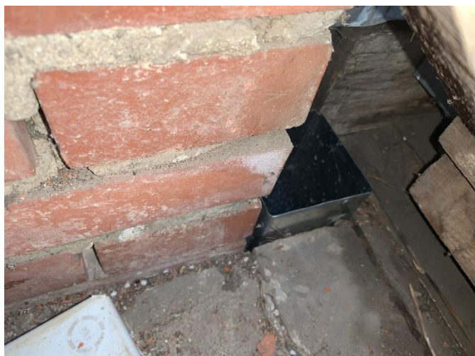
Na controle van het onderdak konden we nergens geen sporen van waterinfiltratie vaststellen
