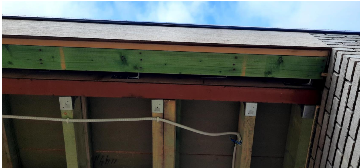
Foto 1 – opbouw van het dak
